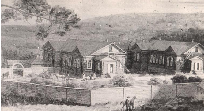
Здание Красноуфимской земской больницы, нач. XX века. В 1940-х годах здесь располагалась Красноуфимская городская больница.
